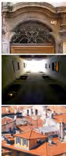
Clairoir et verrières sur puits de jour dans le vieux Nice, sont des dispositifs traditionnels de rafraîchissement.
